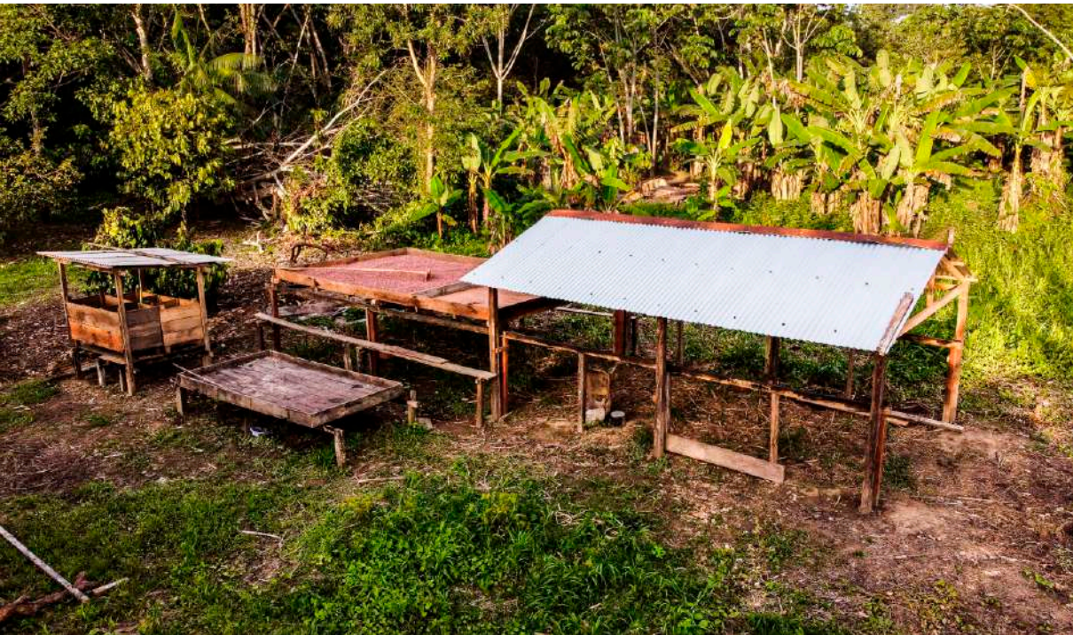
Secador tendal. Lastro de madeira e cobertura de zinco
